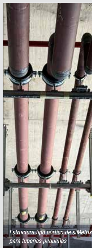
siMetrix conectado directamente a viga de acero
