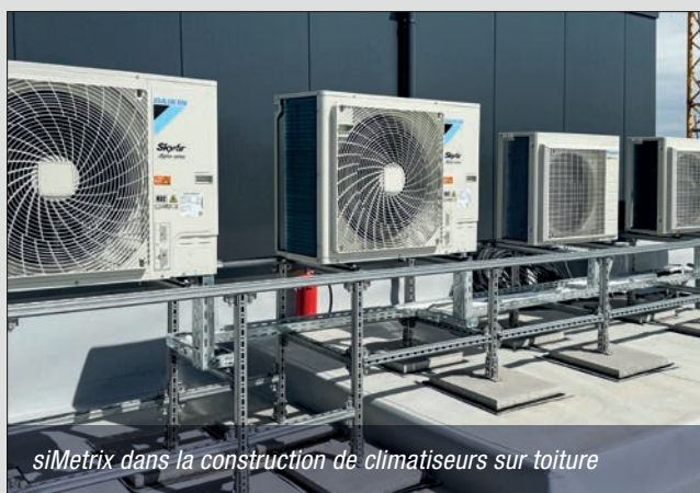
siMetrix en liaison directe avec la poutre en acier
