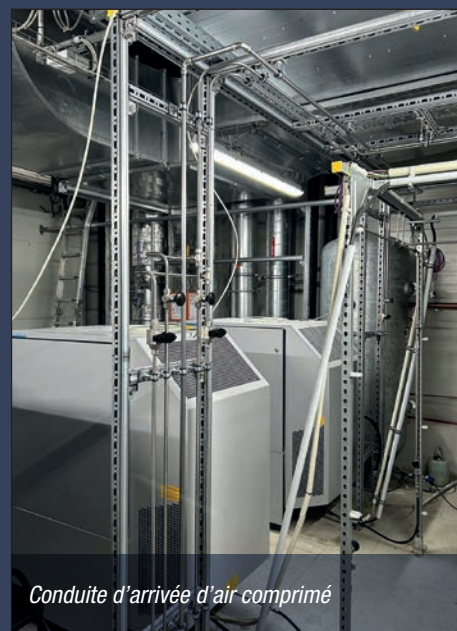
Grille de fixation à 3 dimensions pour les zones à forte densité d'installation et aux exigences élevées en matière de flexibilité.
