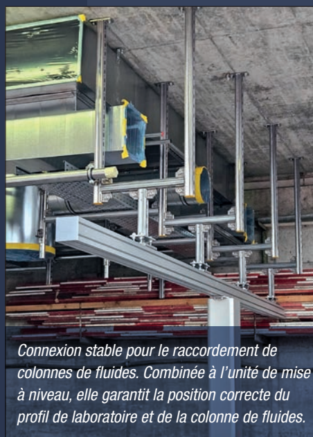
Grille de fixation à 3 dimensions pour les zones à forte densité d'installation et aux exigences élevées en matière de flexibilité.
