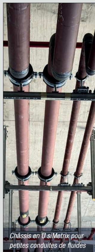
siMetrix en liaison directe avec la poutre en acier
