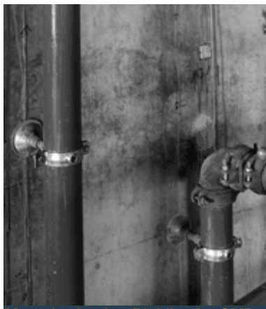
Montaje simple - Rigidizador SMD 1
