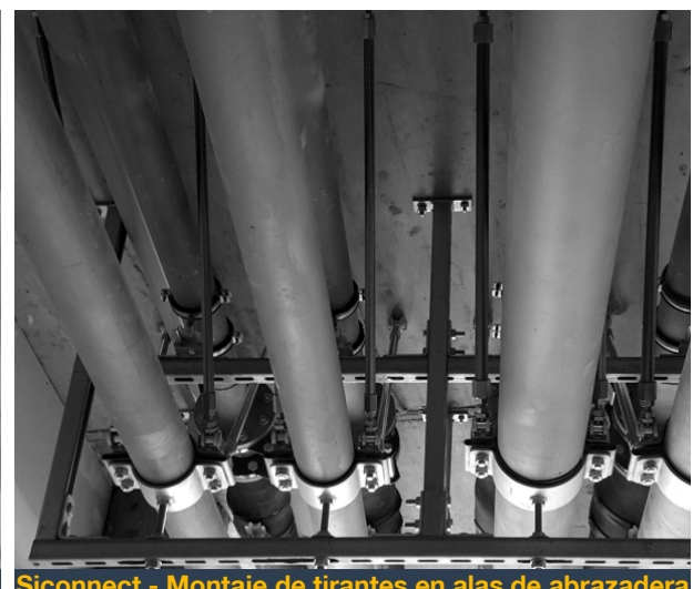
Siconnect - Montaje de tirantes en alas de abrazadera
