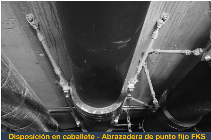
Siconnect - Montaje con tirantes de refuerzo
