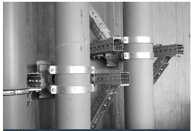
Simotec - Soporte patín convertido a Punto fijo
